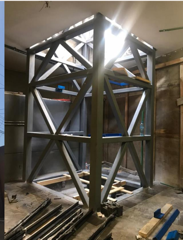
Terminado de estructura en pintura anticorrosiva para recibir fachada integral de cristal nivel banqueta, del elevador Tetlán ingreso sur
