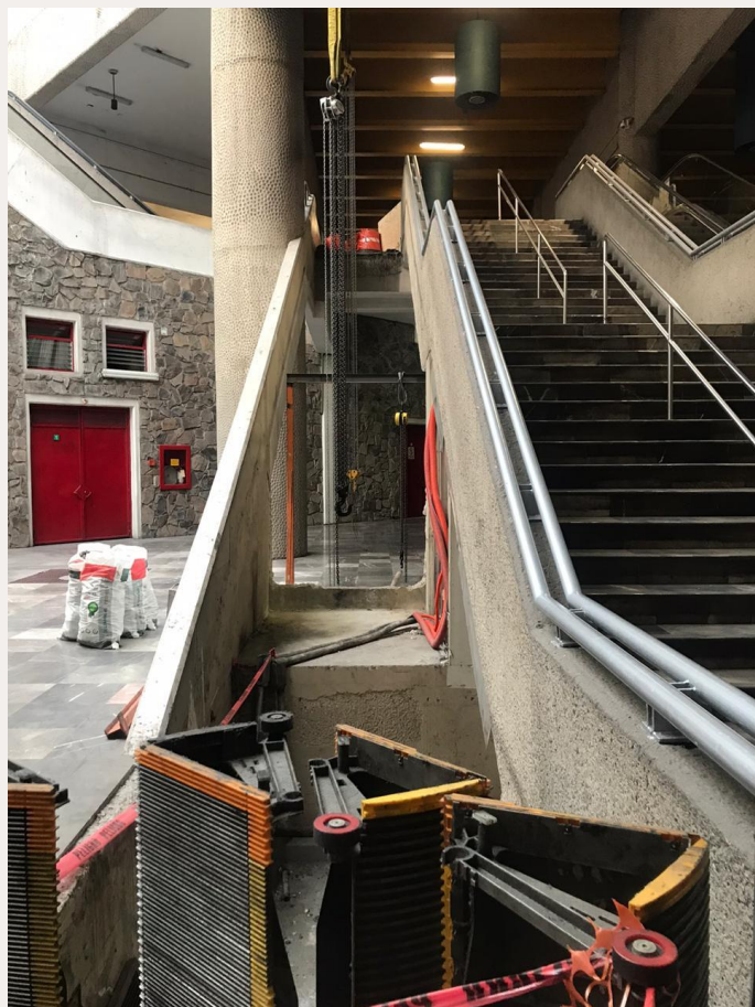
Desmontaje escalera No. 3.
