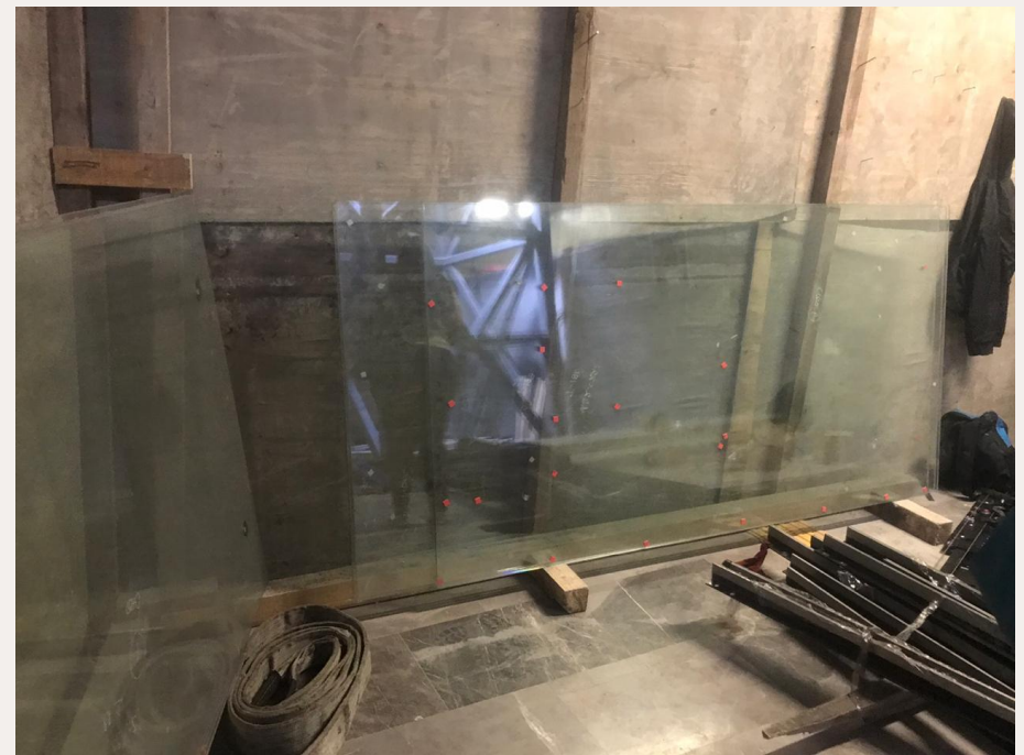
Suministro de fachada integral de cristal nivel de andén elevador Tetlán ingreso sur
