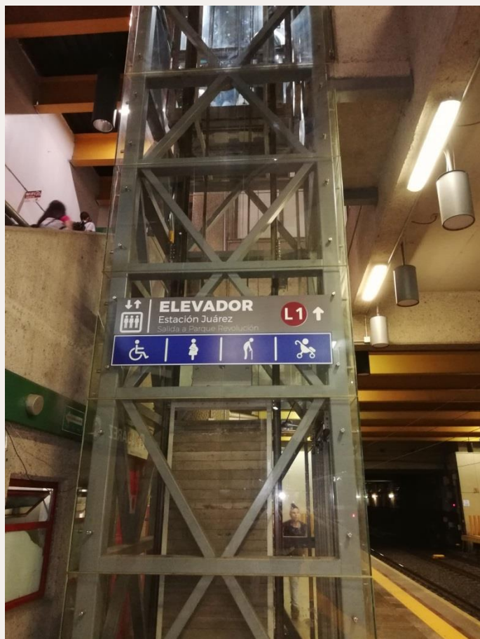
Rehabilitación elevador Vía 1.
