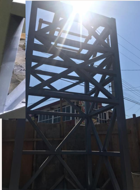
Terminado de estructura en pintura anticorrosiva para recibir fachada integral de cristal nivel banqueta, del elevador Tetlán ingreso sur
