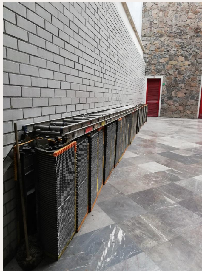
Equipo desmontado escalera No. 3.
