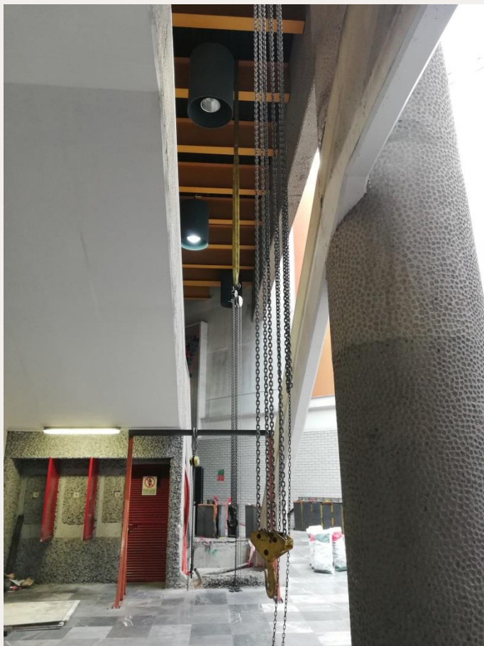
Preparación para montaje escalera No. 3.
