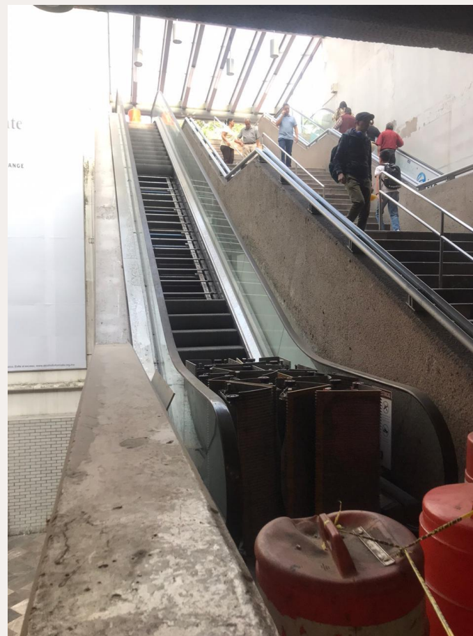
Desmontaje escalera No. 2.
